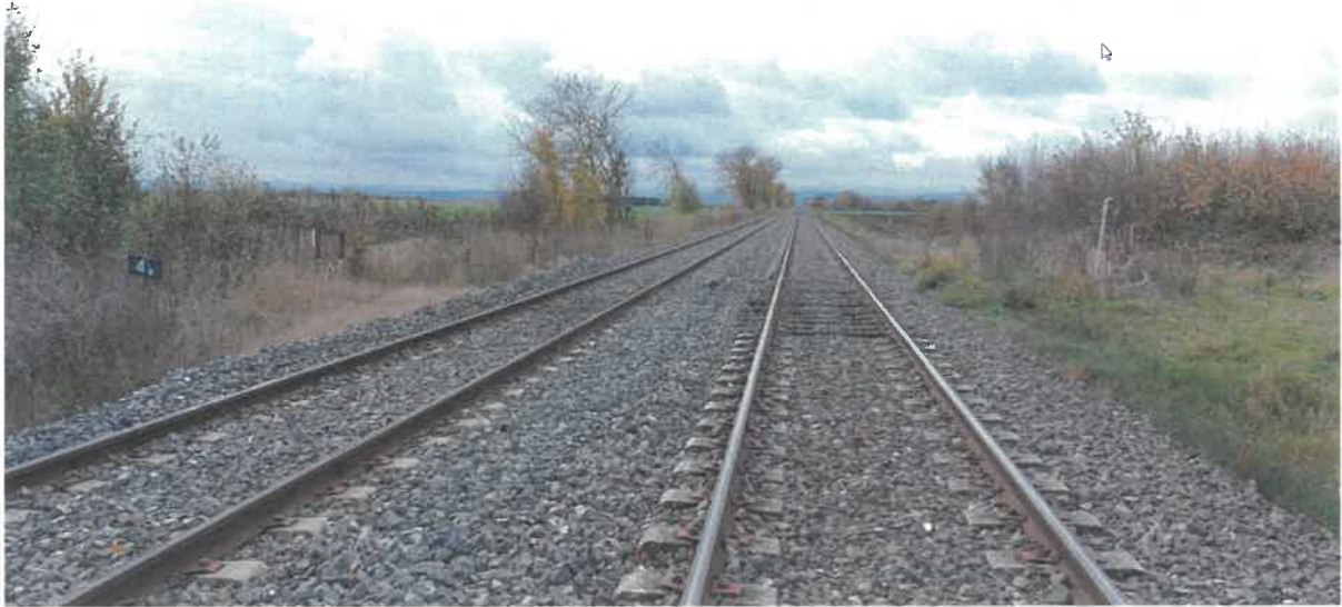
Vue du Passage à niveau direction Gannat (Nîmes)
