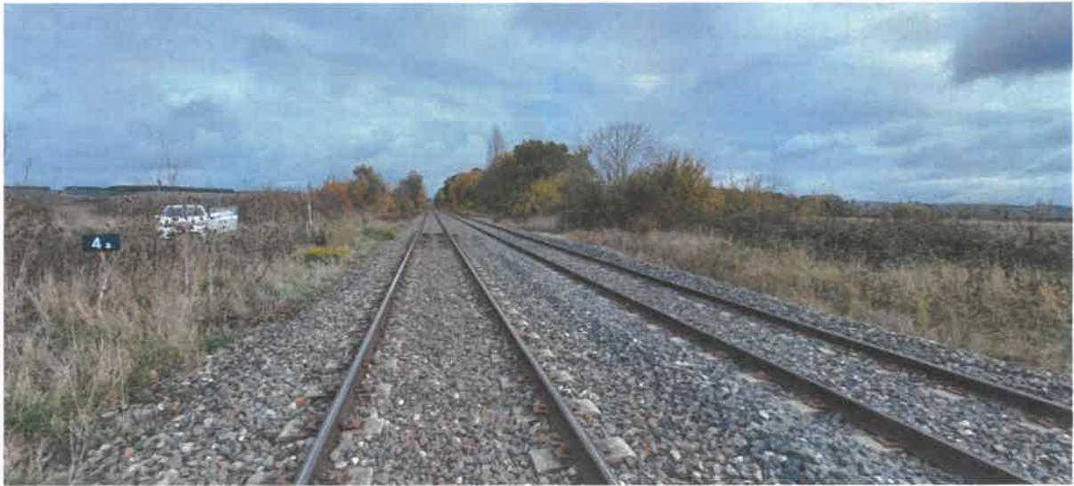
Vue du Passage à Niveau direction St Germain des Fosses
